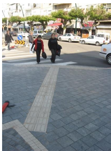
נגישות המבוצעת ללא הבנת הצורך גורמת להנגשה ברמה נמוכה ועלולה ליצור בעיות גדולות יותר. במקרה זה פס מוביל לעיוורים יוביל אותם לאמצע הכביש במקום לצד השני של המדרכה.
